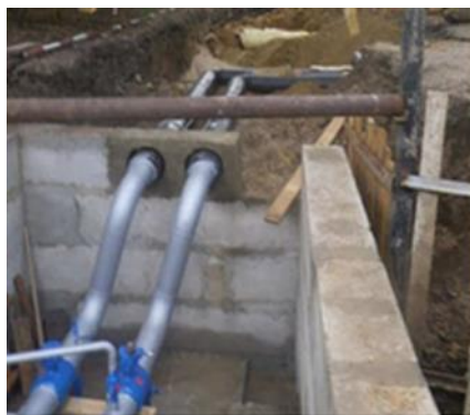
Рисунок 1. Городская теплотрасса на ремонте
